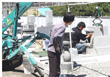
新墓建立のお客様が施工現場を見学に
