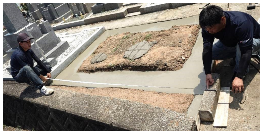
墓石移設工事のための、コンクリート打設工事
